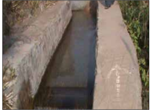
Fig. 15 (d) RCC pipeline outlet of SSD
